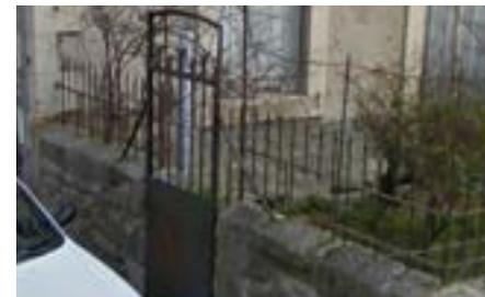
*Mur-bahut maçonné surmonté d'une grille à fers droits*
